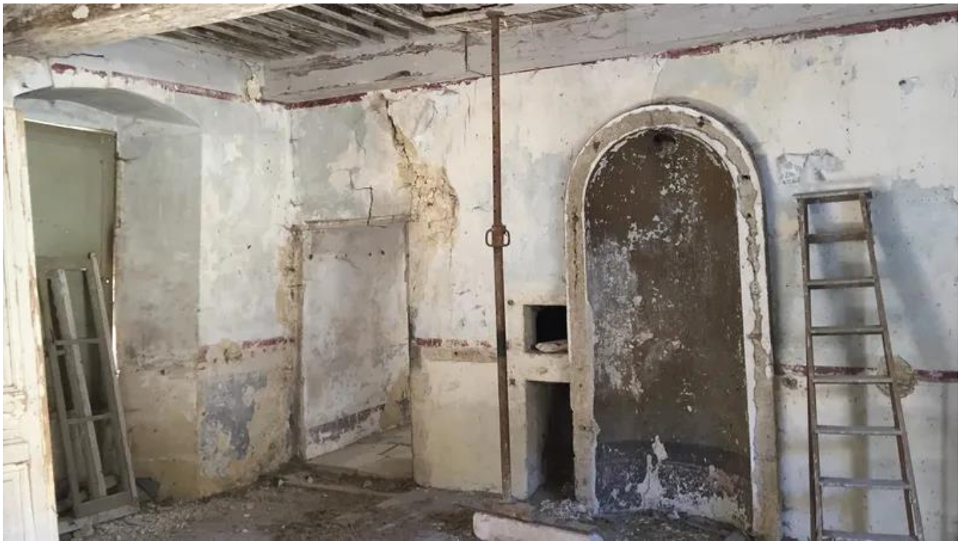
Le musée du prieuré de Mouthier-Haute-Pierre pendant les travaux de restauration • © François Guillin
